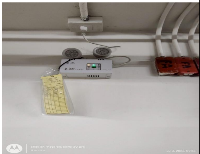
รูปที่ 2.5.7-15 ไฟแสงสว่างฉุกเฉิน
