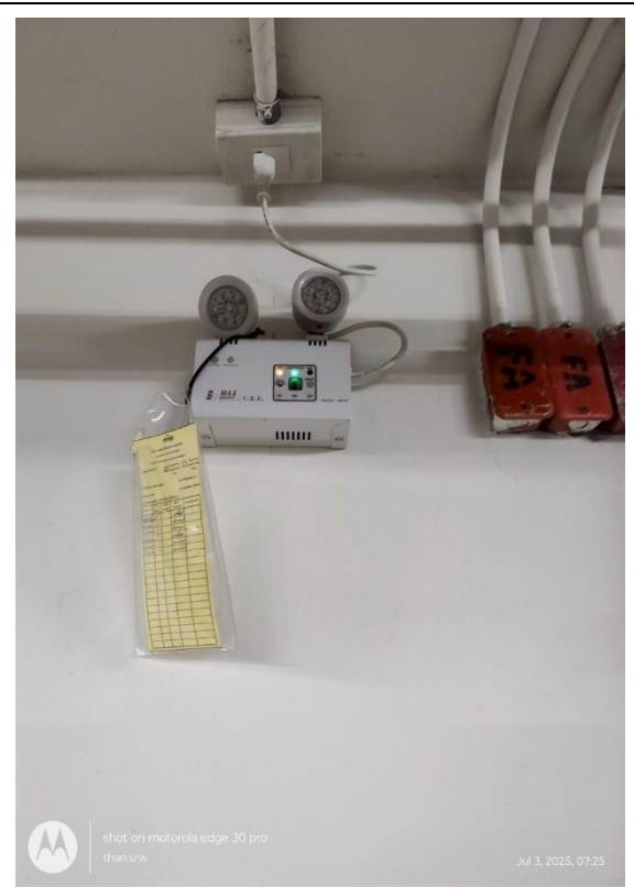
รูปที่ 2.5.6-3 ไฟแสงสว่างฉุกเฉิน
