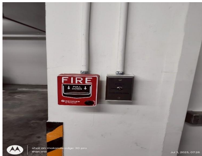
รูปที่ 2.5.7-13 อุปกรณ์แจ้งเตือนด้วยมือ (Manual Pull Station)
